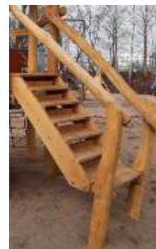
Treppe mit Einstiegs- podest
